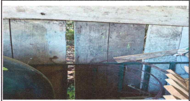
Foto 2: SUSTITUCION DE BARANDAS DE METAL, CON TUBO DE X MEDIDA, CHAPA 16, MAS PINTURA ANTICORROSIVA CELCO R15
