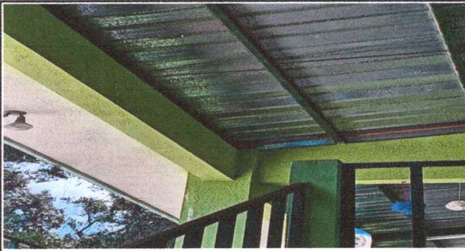
Foto 1: SUTITUCION DE LAMINA TROQUELADA DE ALUZINC CALIBRE 26, MARCA MAXALUM
