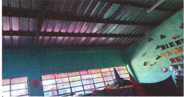
Foto 4: MANTENIMIENTO A ESTRUCTURA DE METAL, LIJADO, PULIDO, APLICACIÓN DE 2 MANOS DE PINTURA ANTICORROSIVA MARCA CELCO R15
