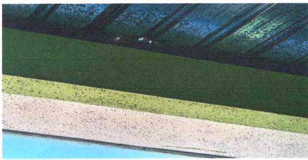
Foto 3: SUTITUCION DE LAMINA TROQUELADA DE ALUZINC CALIBRE 26, MARCA MAXALUM
